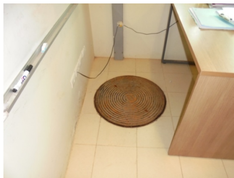
ภาพที่ 3-17 ฝาท่อล้างร่องน้ำใต้ดิน
