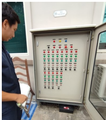
ภาพที่ 3-11 แยกมิเตอร์แผงควบคุมระบบบ่อบำบัดน้ำเสียโดยเฉพาะ
