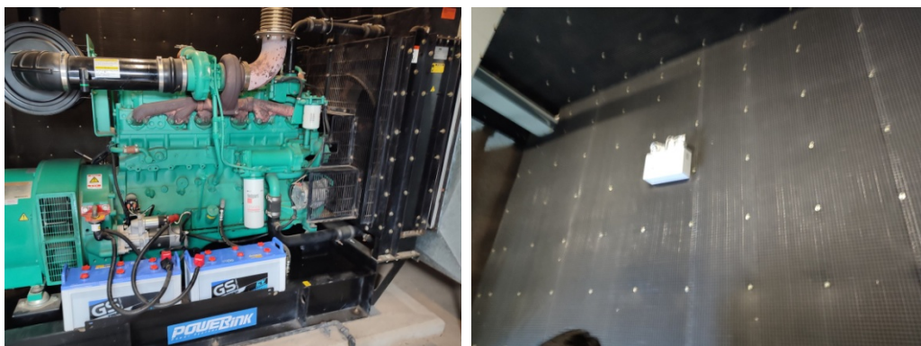
ภาพที่ 3-32 เครื่องกำเนิดไฟฟ้าฉุกเฉิน มีฉนวนกันเสียงดังอยู่ภายในห้อง
