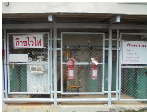
ภาพที่ 3-39 ถังเคมีดับเพลิง ติดตั้งไว้บริเวณที่เก็บถังแก๊ส
