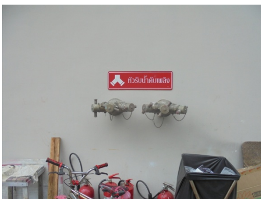
ภาพที่ 3-26 ตรวจสอบระบบป้องกันและเตือนอัคคีภัย พร้อมใช้งาน
