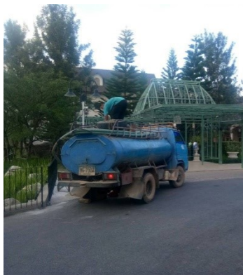
ภาพที่ 3-10 สูบตะกอนออกจากถังแยกตะกอน
